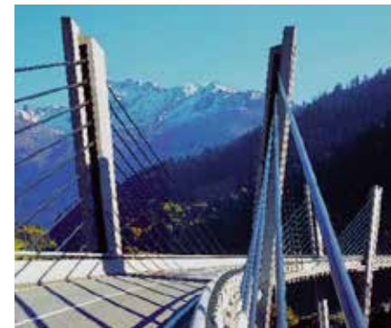
МОСТ KLOSTERS, ШВЕЙЦАРИЯ
