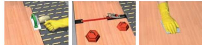
Для соединения деревянных элементов необходимо использовать молоток и подбивочный блок. Необходимо соблюдать требуемое расстояние между стеной и деревянным покрытием 10–15 мм.
