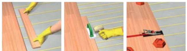
Крепко вдавить деревянное покрытие в слой клея, соблюдая отведенное время на использование нанесенного клея максимум 60 мин.
