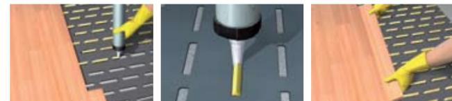
С помощью пистолета заполнить клеем все прорезы мата. Нанести дополнительный валик клея в пространство между двумя матами **SikaLayer®** (маты укладываются на расстоянии мин 13 мм друг от друга, а рекомендуемое расстояние 2–3 см), а также везде, где мат граничит со стеной. Наконечник пистолета держать под углом 90° к основанию.
